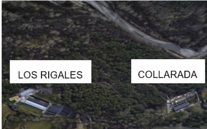
Vista de las instalaciones del Centro acuícola de Villanúa (Huesca)
